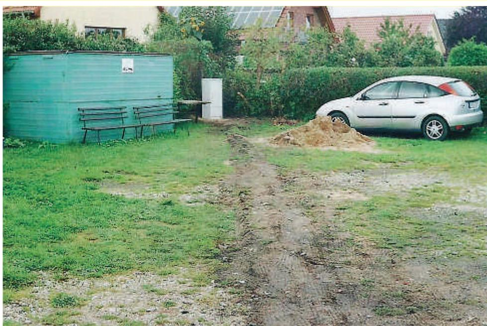
Kabel ins Kiesbett verlegt, Graben wieder zugeschüttet, Strom für die nächsten Jahre gesichert. Rasen wieder angesät, fertig.
